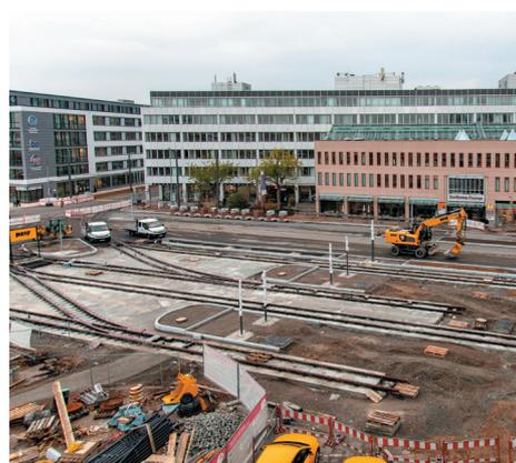
ber 2019 werden hier die Gleise und Weichen erneuert. Die Leitungsarbeiten im Bereich der Gehsteige auf Höhe des Supermarkts gehen auch in dieser Bauphase weiter. Außerdem fällt der Startschuss für den barrierefreien Ausbau der Haltestelle Stadtwerke.
